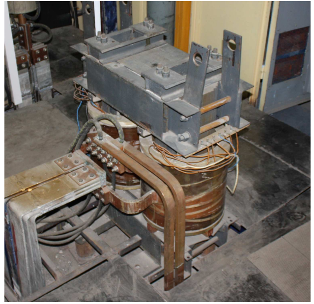
Рис. 3.2. Трансформатор подавления пульсаций.
