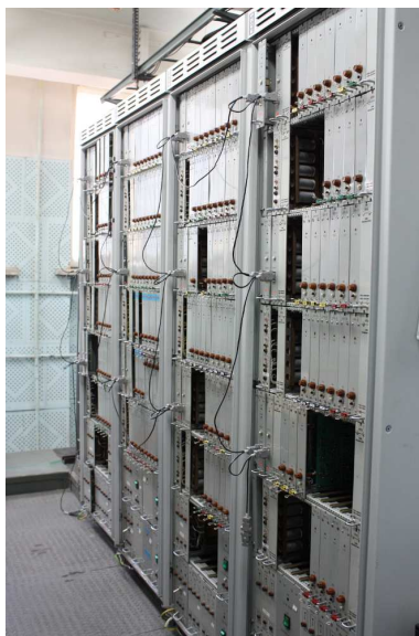
Рис. 3.6. Шкафы с элементами питания УМ-6 и управляющими блоками.
