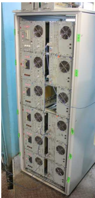
Рис. 3.4. Стойка с источниками ВЧ-300/12, установленная под коллайдером ВЭПП-2000.
