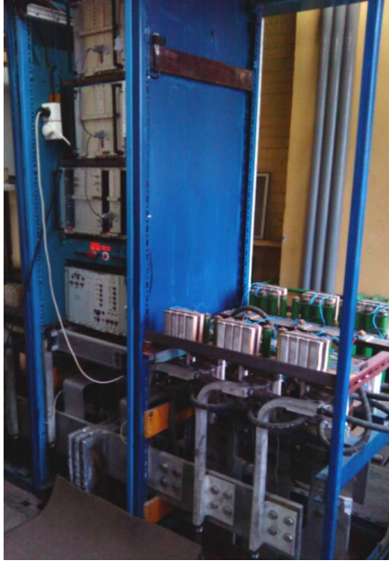
Рис. 3.1. Выпрямительный шкаф ШВ1 и стойка управления.
