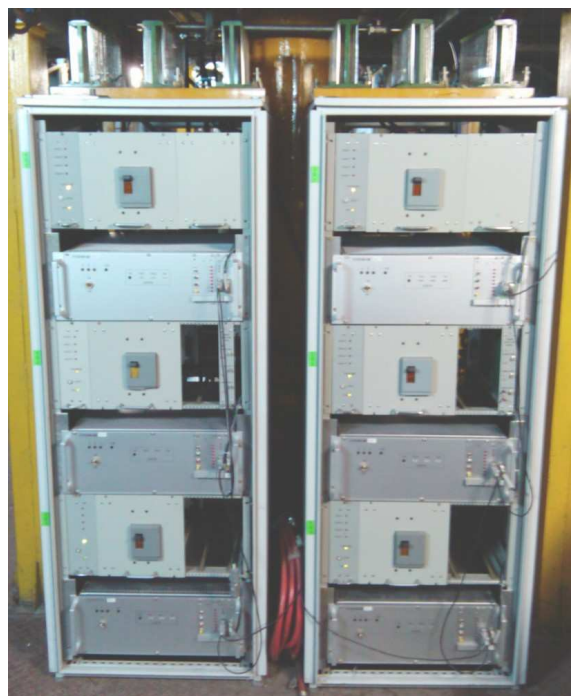
Рис. 3.5. Стойки с источниками VCH-300K и высокоточными ключами.
